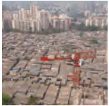
▶インド・ムンバイのスラム再開発現場
